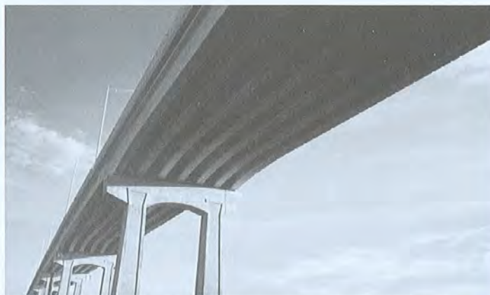
Shark River Bridge, New Jersey USA: 52 Betonträger jeder 54 Meter lang und 100 Tonnen schwer. Sika® ViscoCrete®-20HE ermöglichte hier eine schneller Produktion der Betonelemente durch die Erhöhung der Frühfestigkeit. Für den Kunden bedeutet dies eine Zeitersparnis bzw. die Möglichkeit zur Kapazitätserhöhung.
